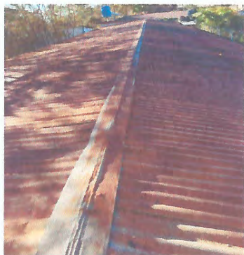
Mantenimiento de cubierta de techo.
