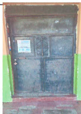
Mejoramiento de puertas.
