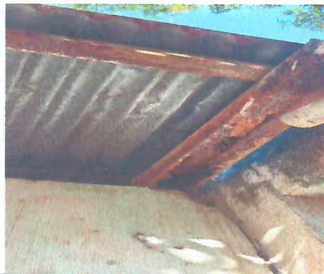
Mejoramiento de cubierta de techo.
